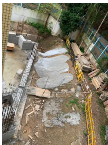
新翼地盤(舊溫室附近)
